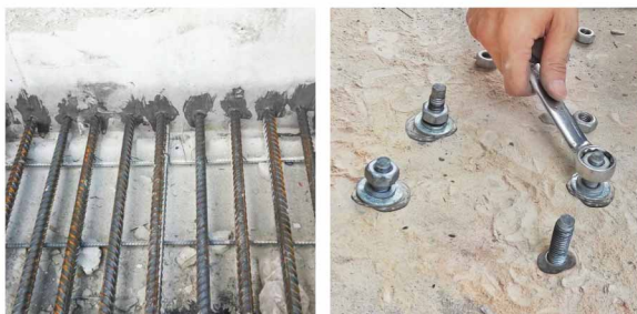
งานเสียบเหล็ก
